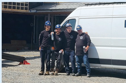
Les confrères Alexis Martinet, Pierre Bédard, Dave Perron et Philippe Mongrain, pour la compagnie Régulvar, sur le chantier de l'école Belle-Vallée, à Maskinongé.
