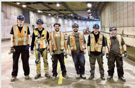
Chantier : Pont-tunnel Joseph-Samson. Entrepreneur : Girouard Entrepreneur Électricien. Travailleurs : Équipe sur place.
