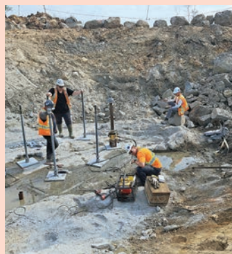
Travailleurs de lignes sur le civil, à St-Félicien.
