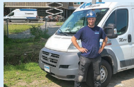
Le confrère Marc Landry, pour la compagnie Val-Mauricie, sur le chantier de l'école Belle-Vallée, à Maskinongé.
