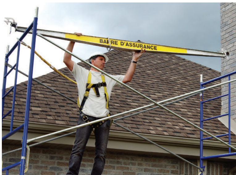
3.2) Ancrage continu rigide, temporaire et amovible
