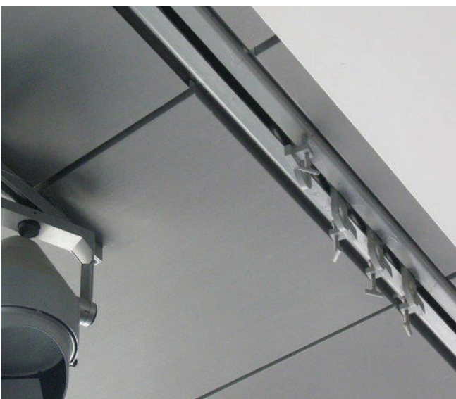
3.1) Ancrage continu rigide et permanent
