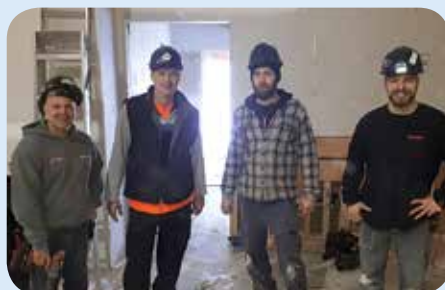
Chantier : Sports BCR. Entrepreneur : Claude Bourque électrique.
