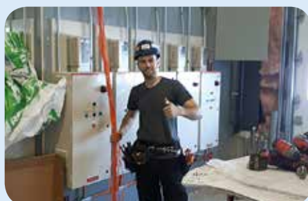
Chantier : Macpek. Entrepreneur : D. G. Tech inc. Travailleur : Michaël Séguin.
