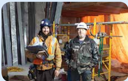
Chantier : Service correctionnel de Donnacona. Entrepreneur : Michel Labrecque inc. Travailleurs : Robert Boulanger (contremaître) et Antoine Mathieu.
