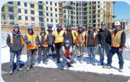
Chantier : Les Faubourgs du Moulin, à Beauport. Entrepreneur : Dalcon inc. Contremaître : Vincent Gagnon.
