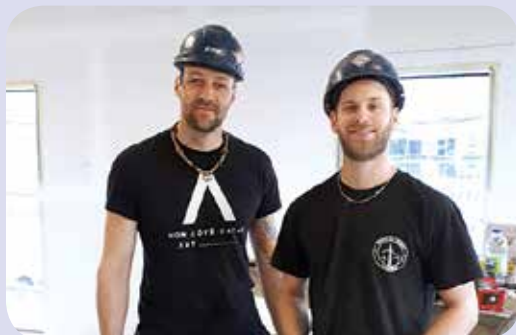
Pour la compagnie Électricité Garon & fils inc., les confrères Dominic Gagnon et Frédéric Arsenault, sur le chantier du Familiprix d'Amqui.
