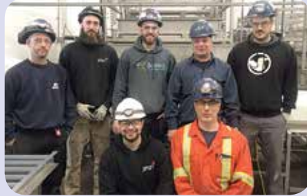
L'équipe de JMN, sur le chantier de l'usine de fruits de mer de l'Est du Québec inc., à Matane. Contremaître : Jean-Philippe Desagnés.
