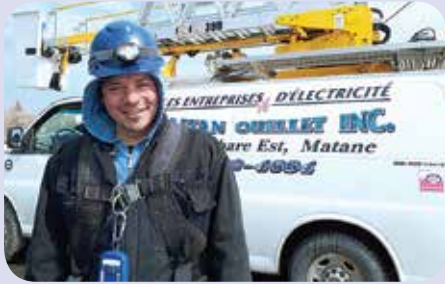
Le confrère Adam Bélanger effectuant des travaux d'éclairage de rue, pour Les Entreprises d'Électricité G. Ouellet inc.
