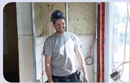
Le confrère Jonathan Bernier, de la compagnie Lepage et Simard inc, sur un chantier résidentiel de 26 logements, à Rimouski.
