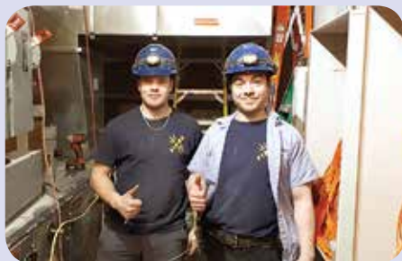
Sur le chantier du CHSLD de Rivière-du-Loup, les travailleurs de la compagnie Régulvar inc. : les confrères Vincent Boudreau et Jean-Simon Laberge.
