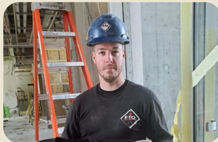
Sur le chantier de la distillerie du St-Laurent à Pointe-au-Père, le confrère Christian Ouellet pour la compagnie Électro 1983 inc.
