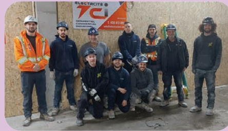
Chantier : Kubik Dorval. Entrepreneur : La compagnie d'électricité CI. Représentant : Hugo Quevillon.
