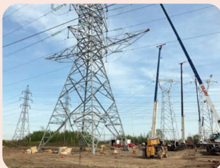
Travailleurs de lignes en action dans un poste à Montréal.
