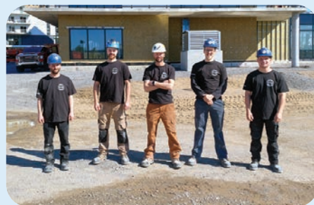
Le contremaître Martin Bourdon, de l'entreprise Marc Cossette inc., en compagnie de nos confrères, sur le chantier de La Tour de la Marina.
