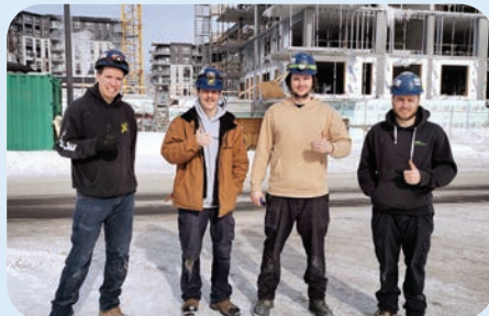
Chantier : Louis IX. Entrepreneur : Moore électrique. Travailleurs : Jean-François Poulin, Raphaël Soucy, Jérôme Lachance et Mathieu Royer. Représentant : Vincent Baux.
