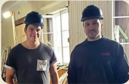
Sur le chantier de l'église de St-Mathieu-de-Rieux, les confrères Alex Lévesque et David Forbes, pour la compagnie Électro 1983 inc.
