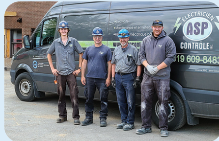
Les confrères Ernest Paris, Sylvain Boisvert, Denis Larouche et Maxime Girardeau, pour la compagnie ASP Contrôle inc., sur un chantier de logements résidentiels à Shawinigan.
