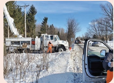
Travailleurs de lignes en action sur un chantier de distribution.
