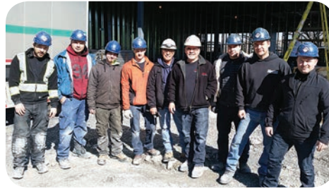
Chantier : Super clinique à Gatineau. Entrepreneur : Marois électrique. Contremaître : René Lachapelle.
