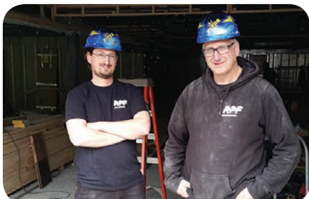
Les travailleurs Mathieu Viel et Patrick Thériault, au chantier de l'Allée des Grands Ormes, à Rimouski, pour la compagnie RPF électrique.
