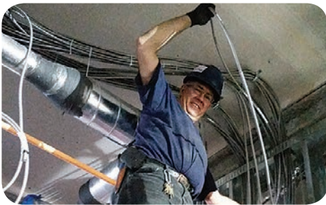
Le confrère Steve St-Amand, sur le chantier du Holiday Inn Express, à l'emploi des Entreprises Danplex inc.
