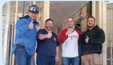
Chantier : Condominiums Ancienne-Lorette. Entrepreneur : MG2 énergie. Contremaître : Donald Labrie. Électriciens : Stéphane Picard et Jonathan McGuire.
