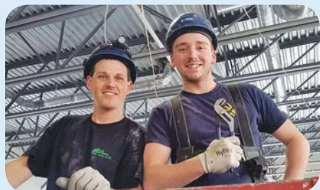
Chantier commercial à Sainte-Hélène-de-Breakeyville. Entrepreneur : Moore électrique inc. Électriciens : Dave Thibodeau et Nicolas Taché.
