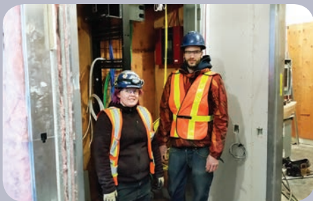
Chantier : Quai Alexandra - débarcadère du Vieux-Port de Montréal. Entrepreneur : CGC électrique. Consœur et confrère Sabrina Terre-Neuve et Dany Paquette Desruisseaux.
