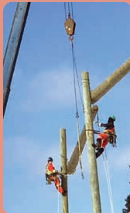
Monteurs de lignes en action, effectuant le démantèlement des travers temporaires.
