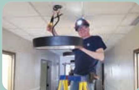
Chantier : Le Monarque. Travailleur : Sylvain Legault. Représentant : Yves Cloutier.
