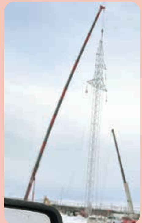
Montage d'un pylône
