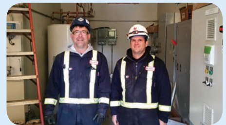
Chantier : Station de pompage de Petite-Rivière-Saint-François. Entrepreneur : Cribtec inc. Les confrères Simon Leblanc (contremaître) et Simon Baril. Représentant : Alain Huot.
