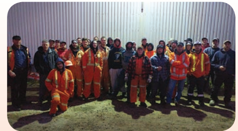
Chantier : La Malbaie - Baie-Saint-Paul 735 kV (Changement d'isolateurs). Délégué : Martin Boivin.
