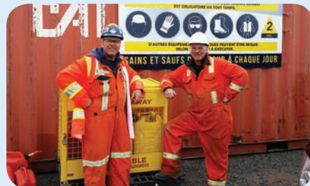
Les confrères Carl Lebel (RDT) et Clément Lemelin, pour la compagnie Thirau, sur l'un des chantiers importants de l'été dans la région, le poste Sainte-Odile-de-Rimouski.
