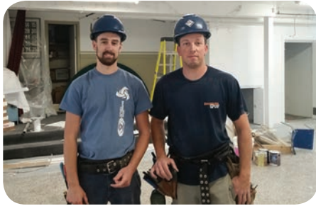
Les travailleurs de la compagnie Électricité Garon & fils, au chantier de la salle municipale de Sainte-Marguerite, situé dans la Matapédia.
