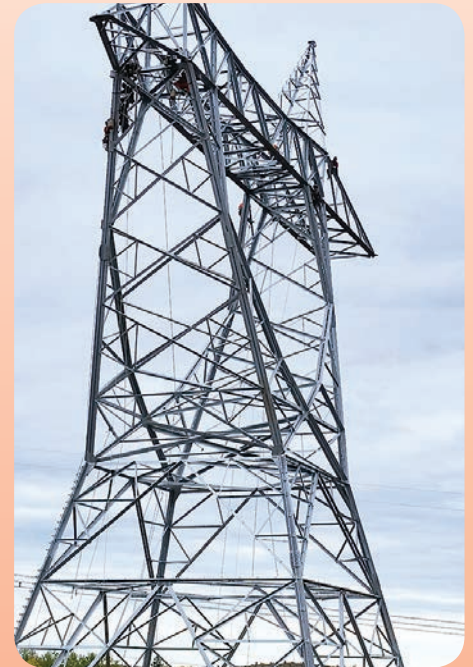
Une brochette de monteurs de lignes!
