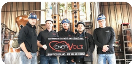
Travailleurs de la compagnie énerVOLT inc., à l'ancienne église de la municipalité de Cap-d'Espoir, en Gaspésie, qui obtient une deuxième vie. Cette dernière a été achetée par quatre jeunes entrepreneurs qui ont fondé la microdistillerie La Société Secrète. Travailleurs : Pascal Athot, Jean-Yves Leblanc, Steve Nicholas, Mathieu Kearney et Frédéric Proulx.
