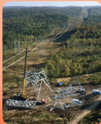
Pylône de quatre pattes.
