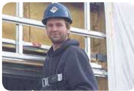
Le confrère Pascal Bélanger, sur le chantier du garage municipal de Rivière-du-Loup, pour la compagnie Les Entreprises électriques Alain Pelletier inc.
