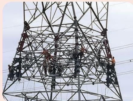
Monteurs de lignes sur un rehaussement de pylône par la méthode Ampjack.
