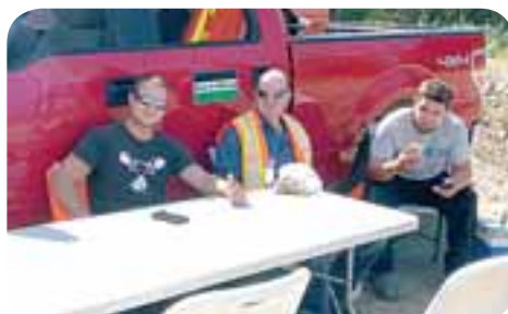
Sur le chantier éolien de Ste-Marguerite. Lorsqu'il fait beau, les gars préfèrent prendre leurs pauses au soleil ! Sur la photo, les confrères Simon Bujold, Roger Francoeur et Yves St-Laurent.
