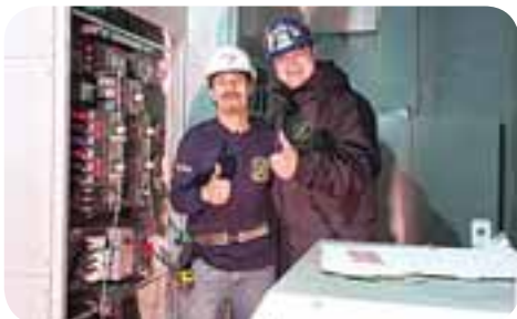
Le confrère Dave Larocque et le contremaître Denis Martineau, de Pierre Boily électrique.
