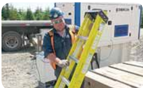
Le confrère Sébastien Roussy, travaillant sur les génératrices du chantier éolien de Ste-Marguerite.
