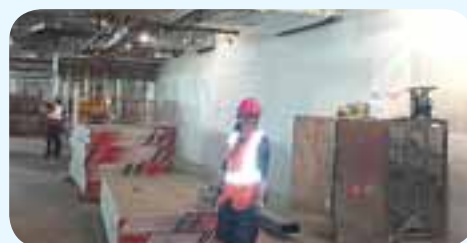
Chantier : CHUM. Entrepreneur : Les entreprises EG. La consœur Audrey Neveu.
