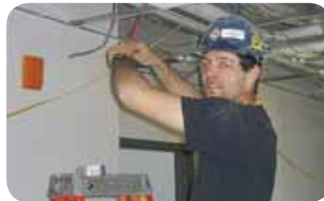
De la compagnie Richard Poirier & frères, le confrère Michael Fortin, au chantier du couvent des Sœurs de Rivière-du-Loup.
