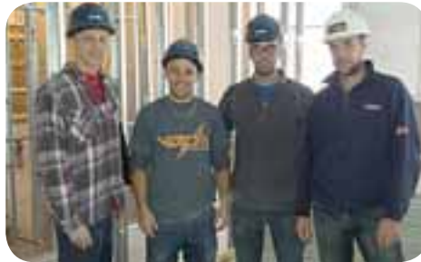
Chantier : Clinique dentaire Bromont. Entrepreneur : Volta électrique. Contremaître : Vincent Desrochers.
